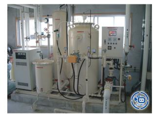
安田町デイ建設当時、日本一の鮎の清流 安田川へ浴槽水の塩素排水による生 態系への影響を考慮して、環境保全対策として完オゾを導入し、18年間事故も なく完オゾを使用。
