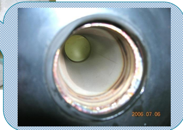
ろ過機配管内(完オゾ型機使用)
