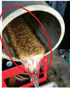
全体に水がかかろうよう通水
